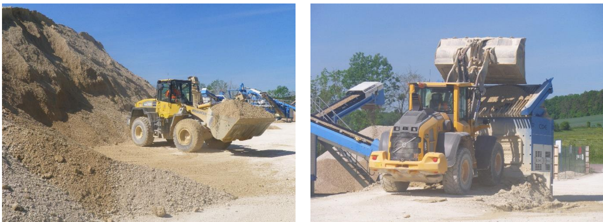
Figure 5 : Chargement des matériaux extraits dans la trémie d'alimentation (ENCEM)
