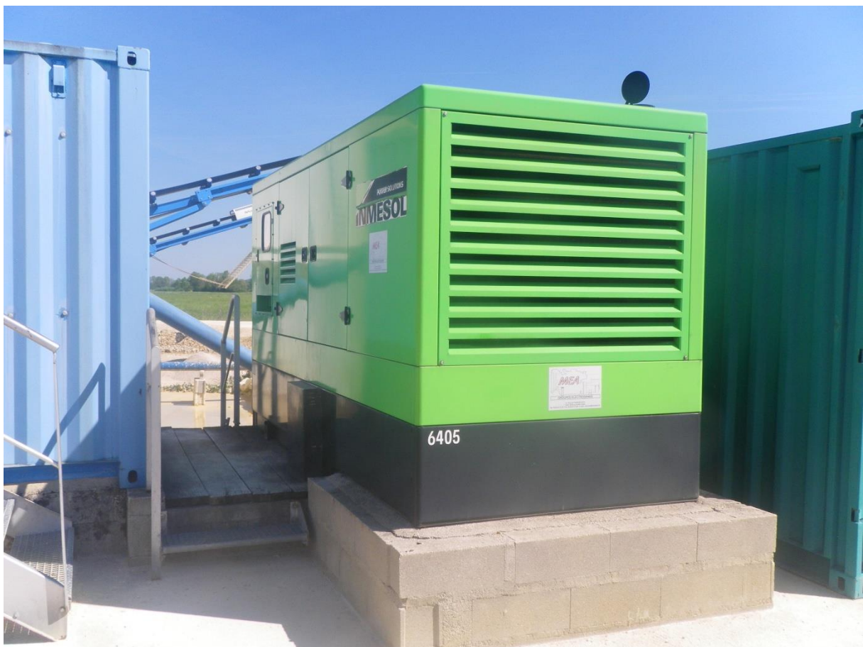
Figure 18 : Groupe électrogène utilisé pour le fonctionnement des unités de traitement des matériaux et l'alimentation en électricité des locaux (ENCEM)
