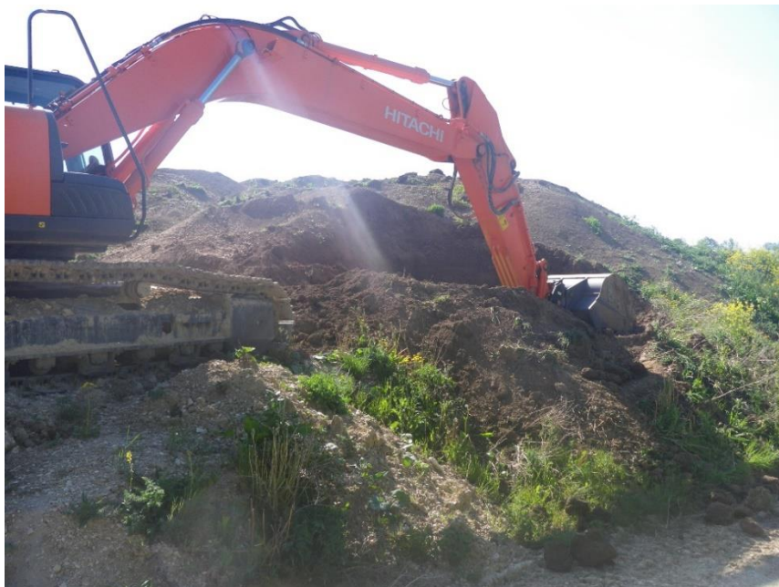
Figure 3 : Merlon de découverte en cours de reprise pour le réaménagement de la carrière actuelle (ENCEM)
