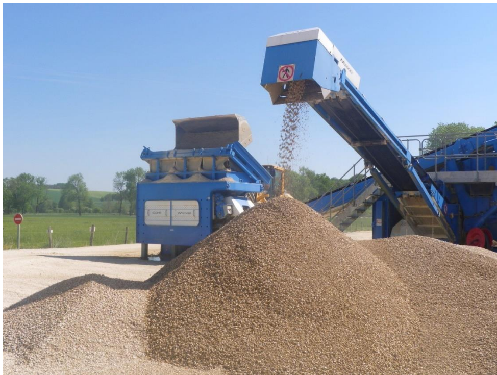
Figure 15 : Produits roulés - lavés après passage dans l'installation de traitement (ENCEM)
