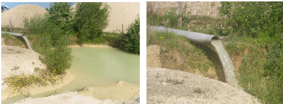
Figure 13 : Rejet des eaux de procédé clarifiées dans le bassin de rejet / pompage (ENCEM)
