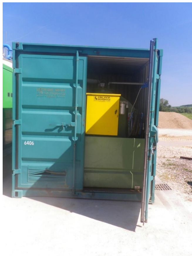
Figure 17 : Cuve de rétention du carburant mise en place dans un container, au droit de l'aire étanche du site (ENCEM)
