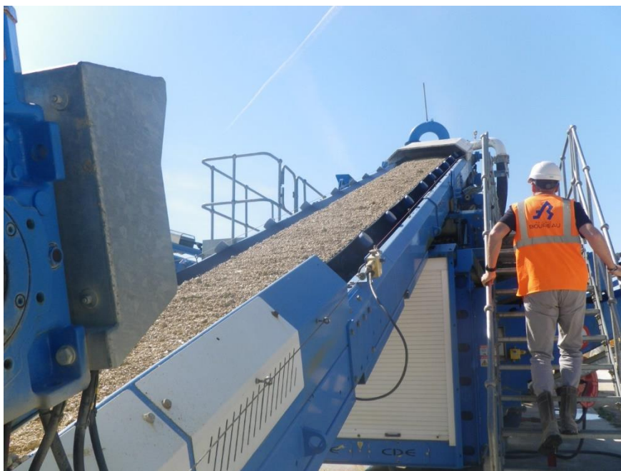
Figure 8 : Convoyeur alimentant l'installation de traitement en matériaux (ENCEM)
