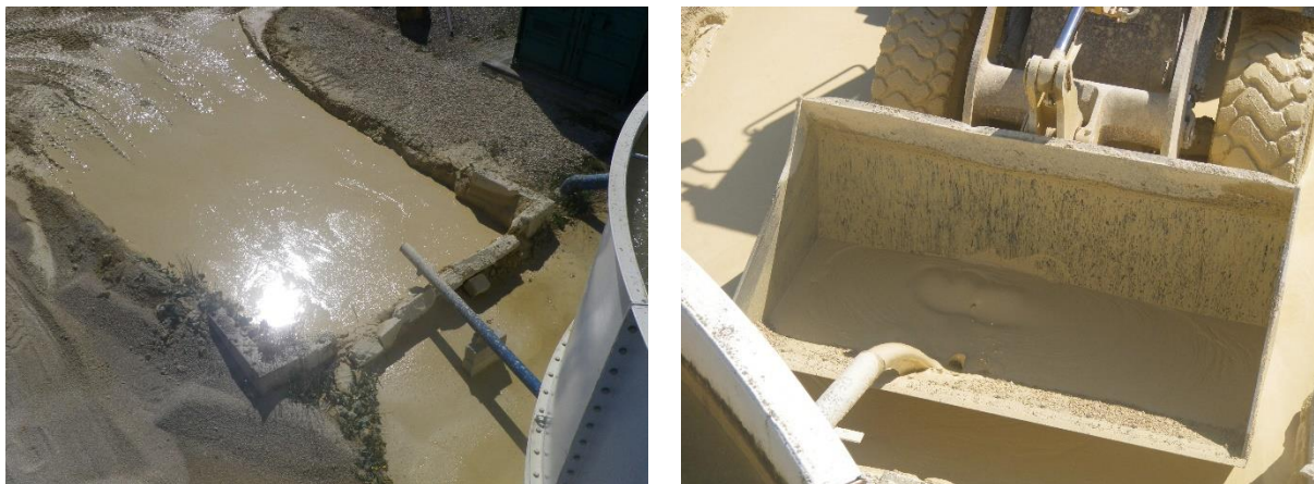
Figure 10 : Bassin de récupération de la pulpe en sortie de réservoir épaisseur (ENCEM)
